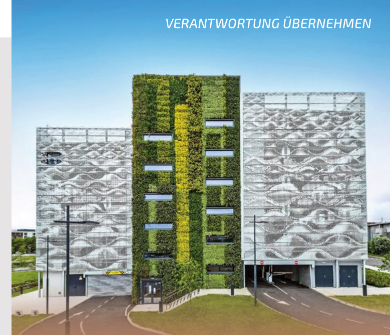
Für das Sunderland City Council realisierte GOLDBECK ein Parkhaus, das mit dem British Parking Award in der Kategorie „Best New Car Park 2023“ ausgezeichnet wurde.
