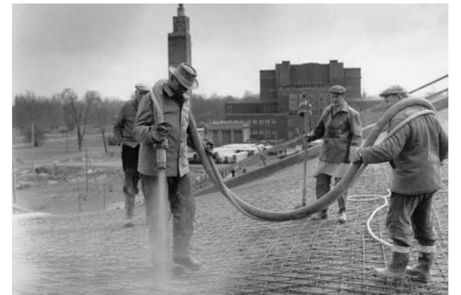
Betonierung der Hyparschale, 1968
