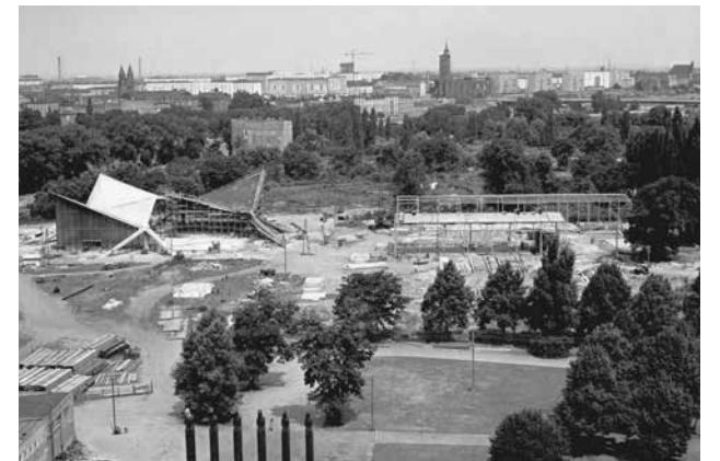
Bau der Hyparschale, 1968
