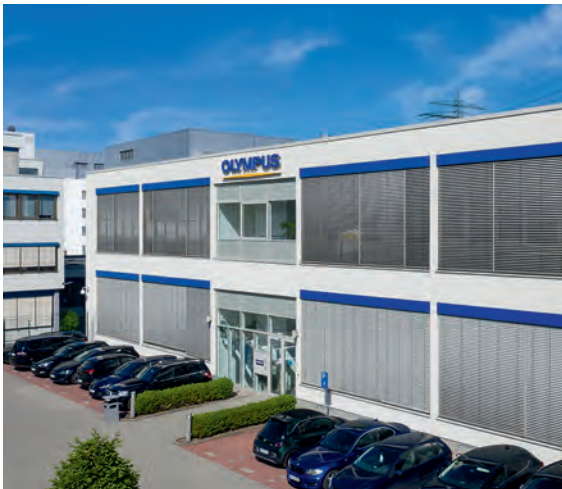
Built-to-suit-Unternehmensimmobilie für Olympus in Hamburg-Tonndorf
