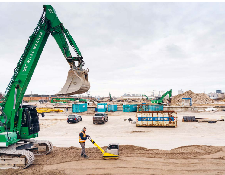
Demolition work at Überseezentrum 2022 (Photo: Thomas Hampel)
